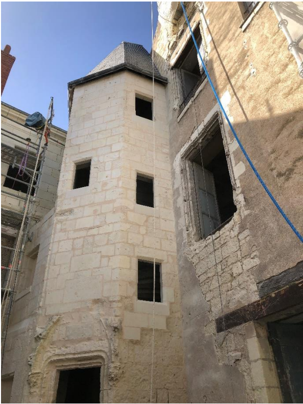
Visite d'un hôtel particulier en cours de restauration, avec les explications du propriétaire.
